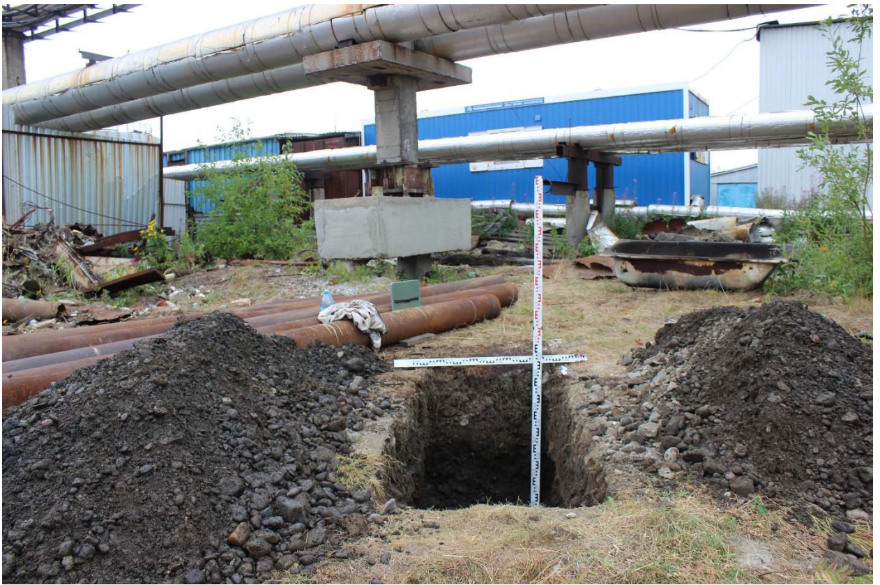
Рис. 23. «Строительство газопровода от котельной № 7 до котельной «Дукла» и газопоршневой электростанции мощностью 3МВт», Красноярский край, Таймырский Долгано-Ненецкий муниципальный район, г. Дудинка, 2024 г. Шурф № 1. Общий вид шурфа. Фото с юга.
