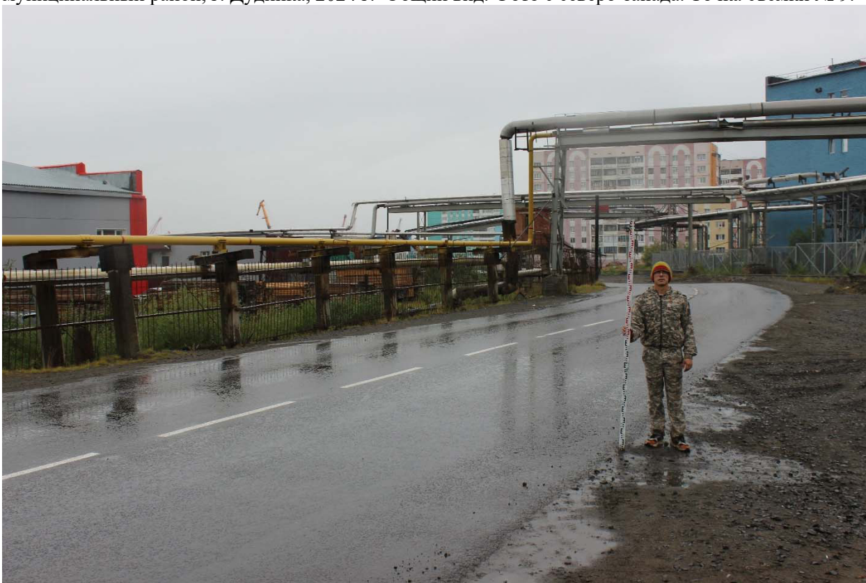
Рис. 20. «Строительство газопровода от котельной № 7 до котельной «Дукла» и газопоршневой электростанции мощностью 3МВт», Красноярский край, Таймырский Долгано-Ненецкий муниципальный район, г. Дудинка, 2024 г. Общий вид. Фото с юго-востока. Точка съемки № 10.
