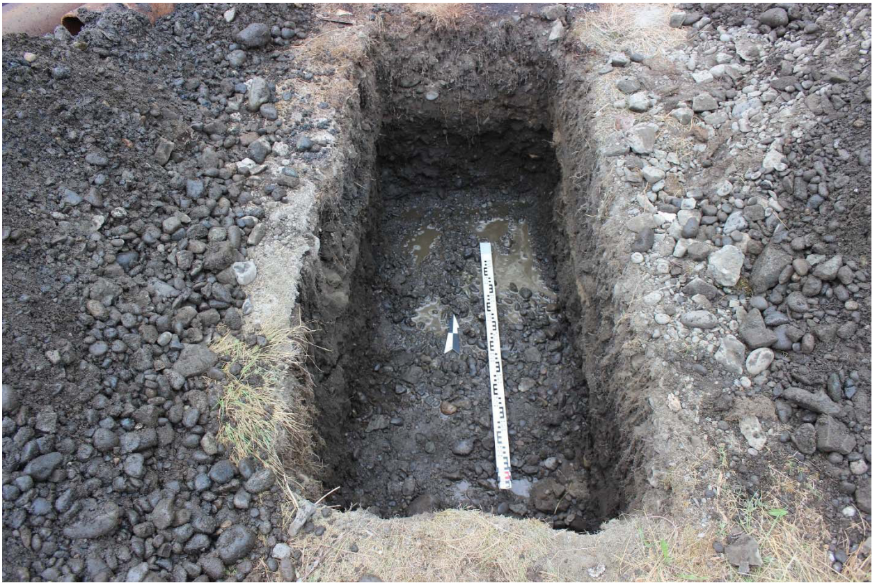
Рис. 25. «Строительство газопровода от котельной № 7 до котельной «Дукла» и газопоршневой электростанции мощностью 3МВт», Красноярский край, Таймырский Долгано-Ненецкий муниципальный район, г. Дудинка, 2024 г. Шурф № 1. Северная стенка. Дно шурфа. Фото с юга.
