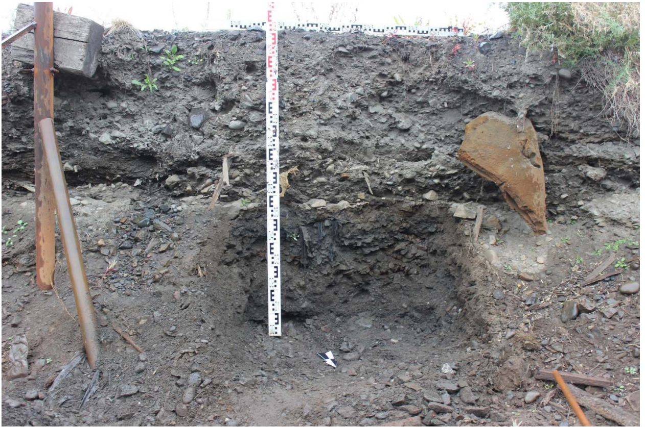
Рис. 29. «Строительство газопровода от котельной № 7 до котельной «Дукла» и газопоршневой электростанции мощностью 3МВт», Красноярский край, Таймырский Долгано-Ненецкий муниципальный район, г. Дудинка, 2024 г. Зачистка № 1. Юго-западная стенка. Фото с северо-востока.
