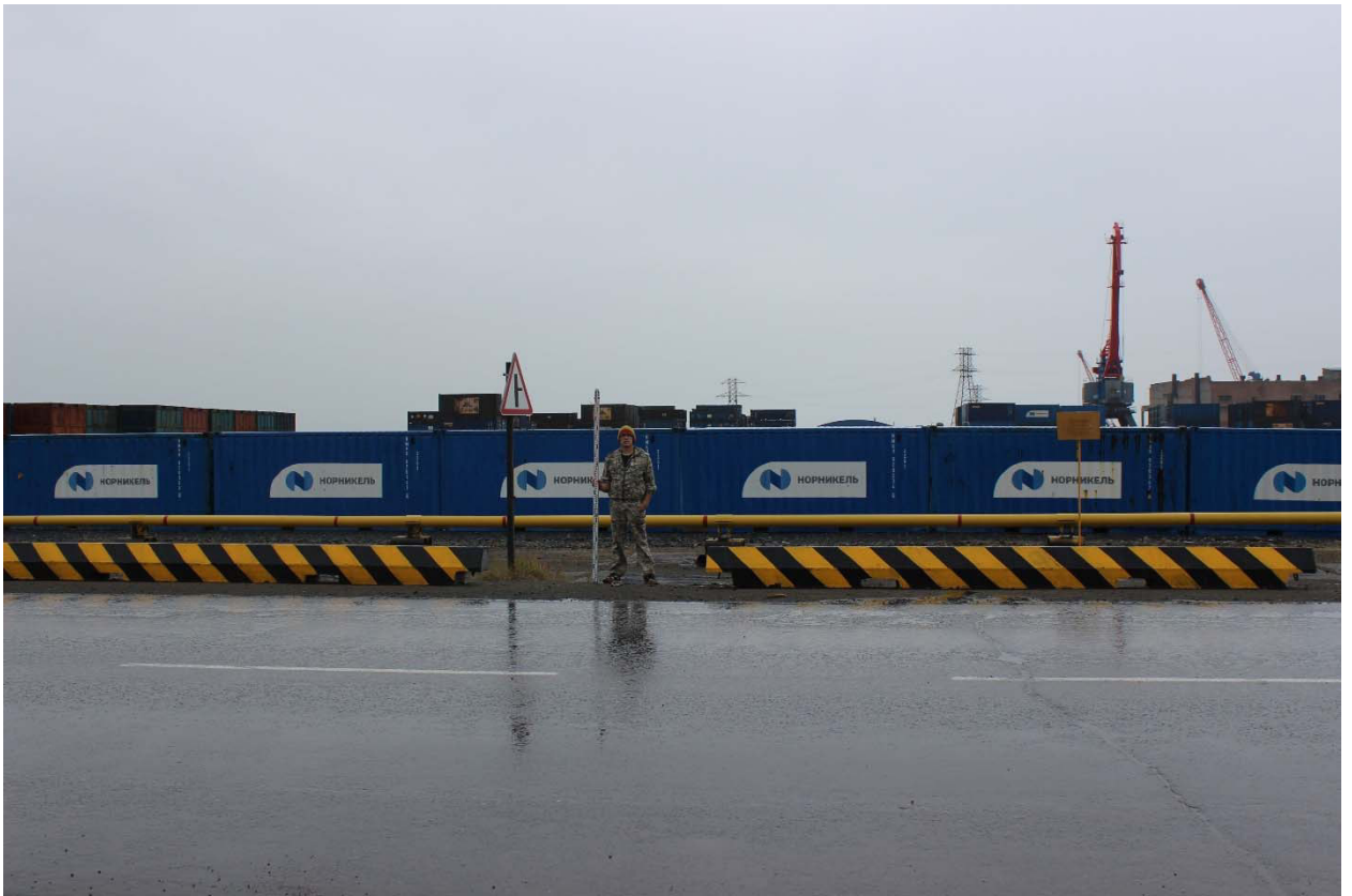
Рис. 15. «Строительство газопровода от котельной № 7 до котельной «Дукла» и газопоршневой электростанции мощностью 3МВт», Красноярский край, Таймырский Долгано-Ненецкий муниципальный район, г. Дудинка, 2024 г. Общий вид. Фото с северо-востока. Точка съемки № 5.
