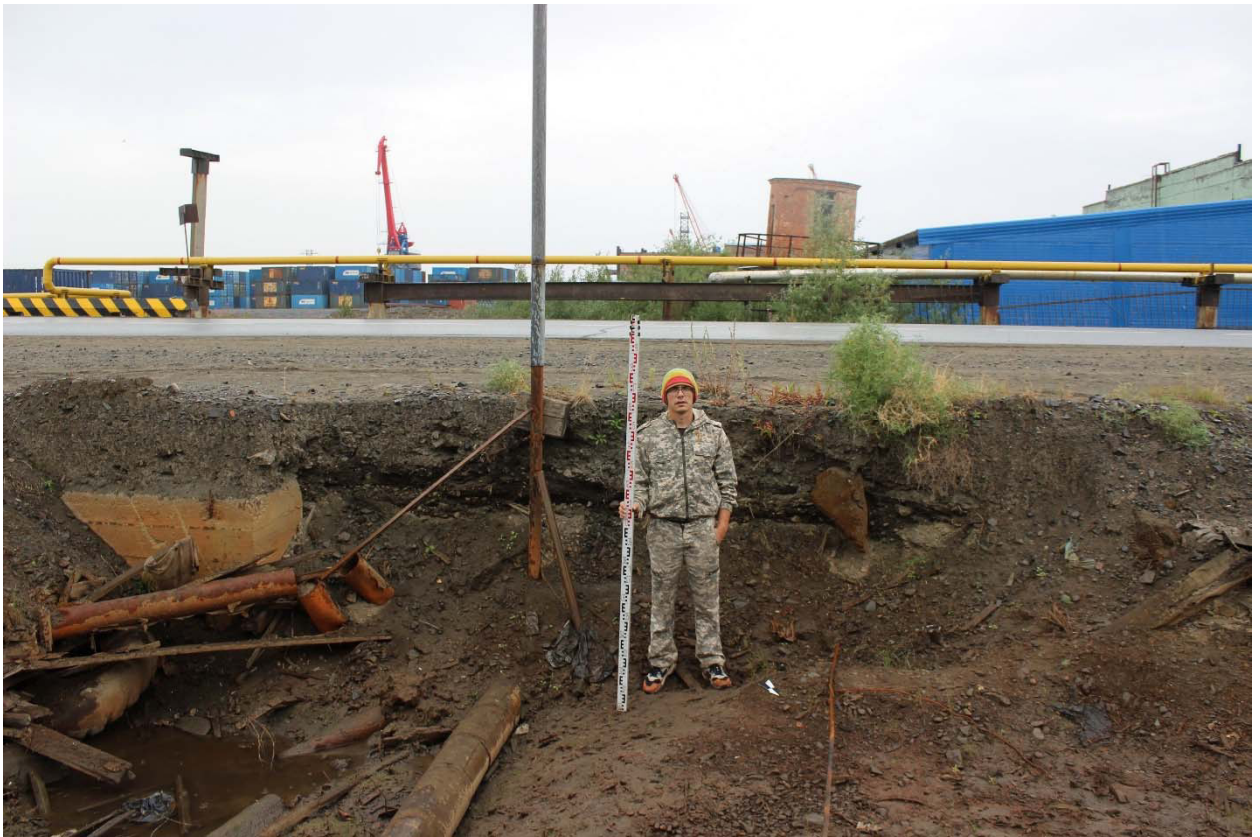
Рис. 27. «Строительство газопровода от котельной № 7 до котельной «Дукла» и газопоршневой электростанции мощностью 3МВт», Красноярский край, Таймырский Долгано-Ненецкий муниципальный район, г. Дудинка, 2024 г. Зачистка № 1. Общий вид до начала работ. Фото с северо-востока.
