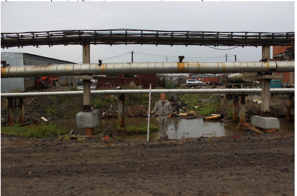
Рис. 12. «Строительство газопровода от котельной № 7 до котельной «Дукла» и газопоршневой электростанции мощностью 3МВт», Красноярский край, Таймырский Долгано-Ненецкий муниципальный район, г. Дудинка, 2024 г. Общий вид. Фото с юго-запада. Точка съемки № 2.
