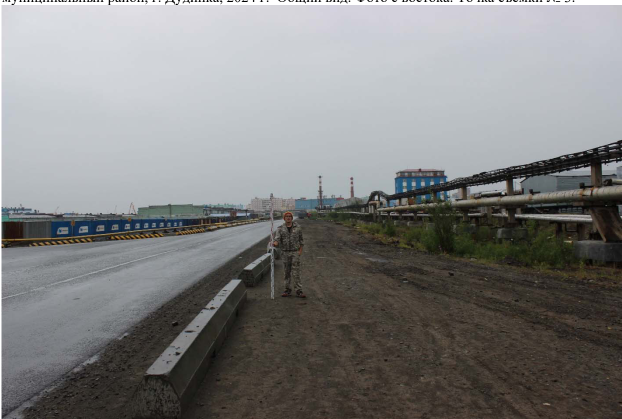
Рис. 14. «Строительство газопровода от котельной № 7 до котельной «Дукла» и газопоршневой электростанции мощностью 3МВт», Красноярский край, Таймырский Долгано-Ненецкий муниципальный район, г. Дудинка, 2024 г. Общий вид. Фото с юго-востока. Точка съемки № 4.
