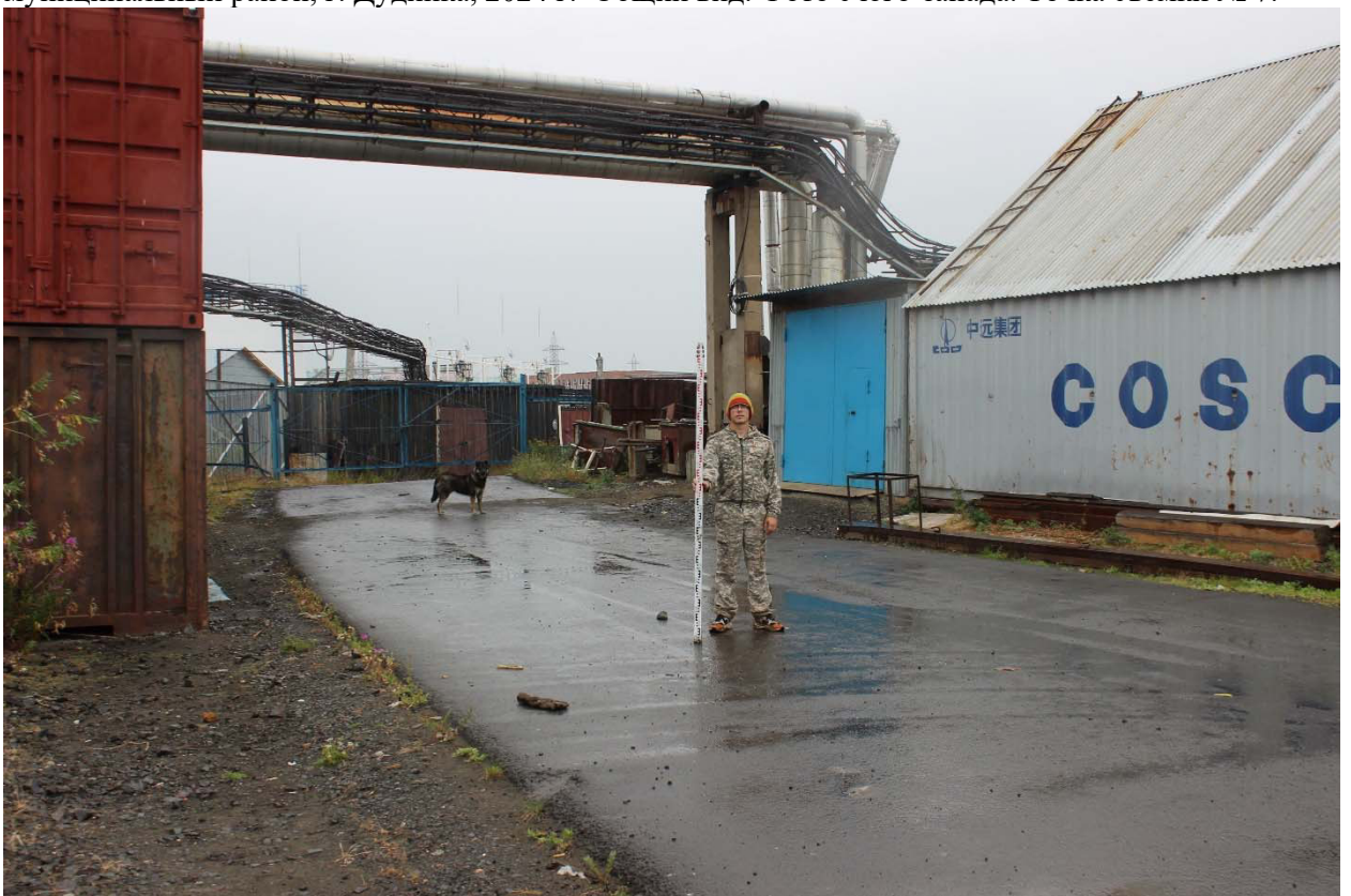
Рис. 18. «Строительство газопровода от котельной № 7 до котельной «Дукла» и газопоршневой электростанции мощностью 3МВт», Красноярский край, Таймырский Долгано-Ненецкий муниципальный район, г. Дудинка, 2024 г. Общий вид. Фото с юго-запада. Точка съемки № 8.
